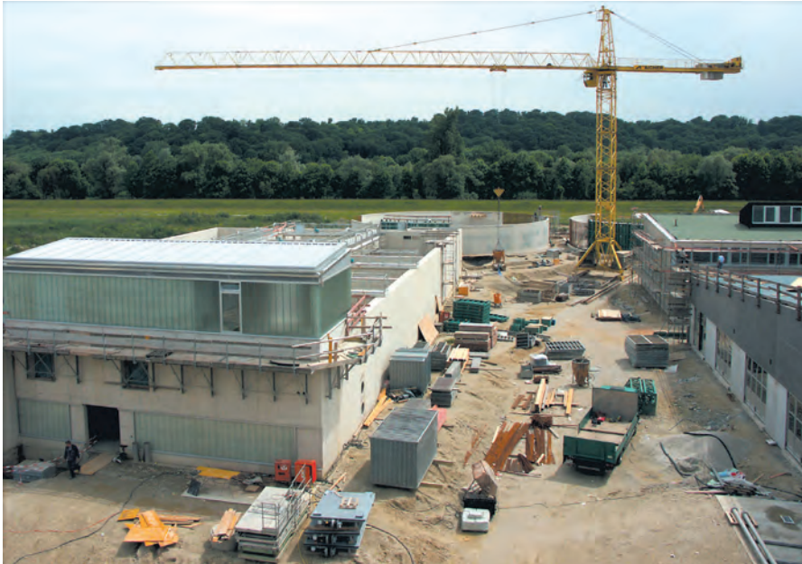
Blick über die Baustelle: links das Maschinenhaus, rechts die Schlammbehandlung und im Hintergrund die Nachklärung
