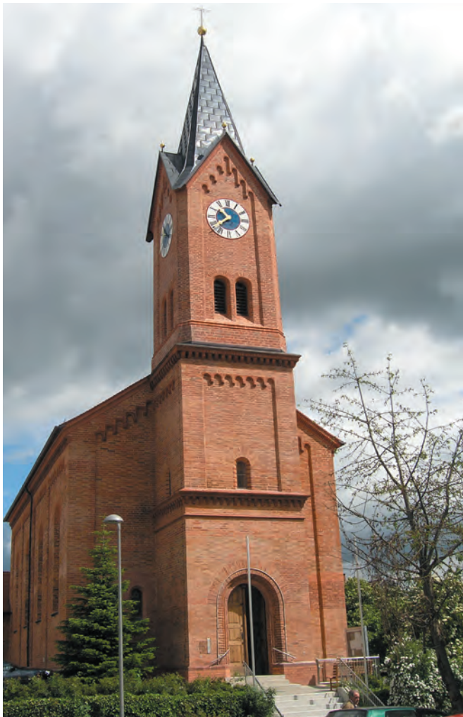
Gelungene Renovierung: die Kirche St. Vitus in Teisbach
