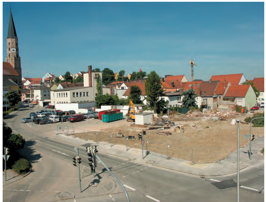
Das Areal der geplanten Tiefgarage
