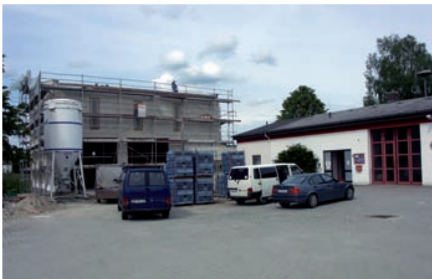
Links der Erweiterungsbau am Gerätehaus Höfen
