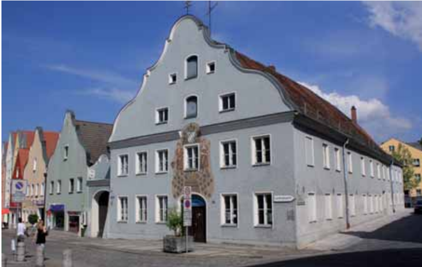
Wird zur Kreis- und Stadtbibliothek: das ehemalige Gasthaus Seethaler
