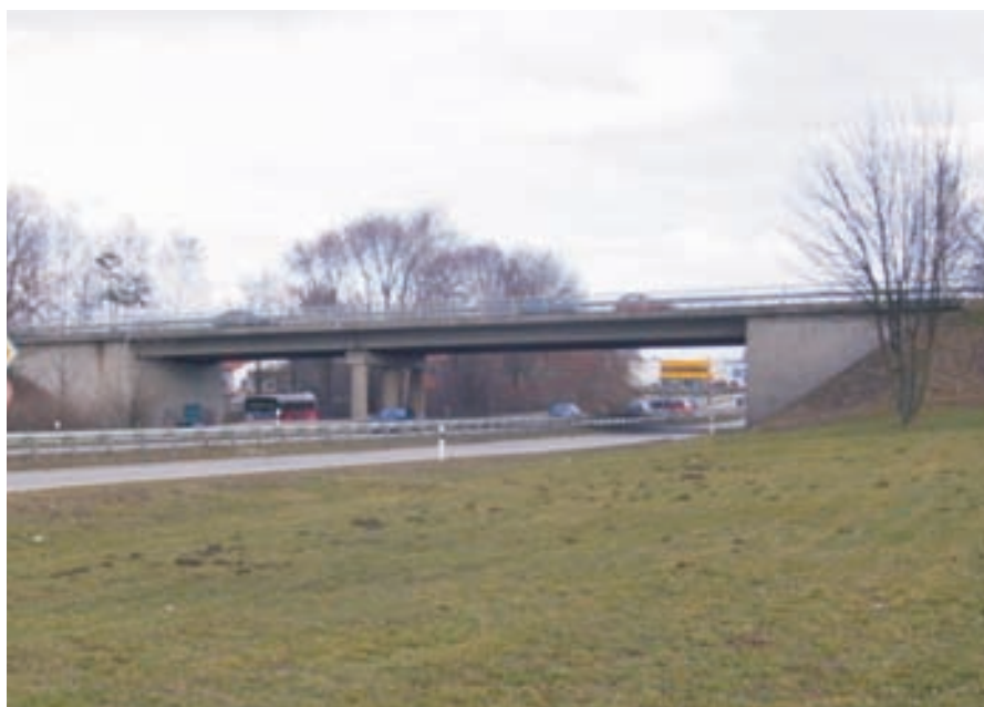
Brücke an der Brumather Straße
