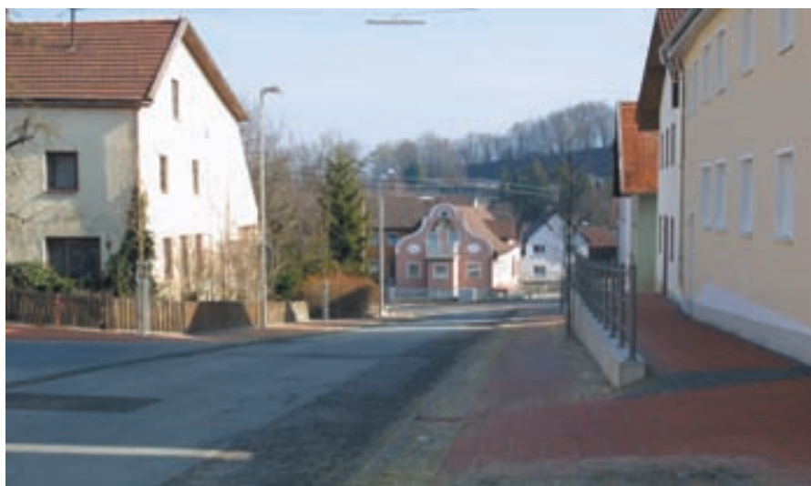
Derzeitiger Baustand am Marktplatz
