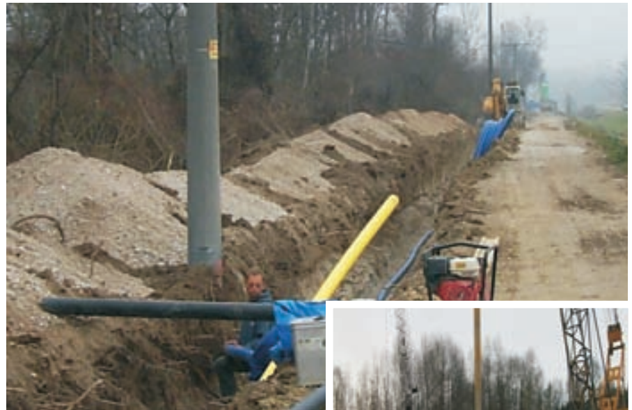
Trassenbau für die Erschließungsleitungen
