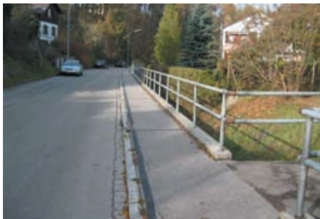
Die zu sanierende Stützmauer
