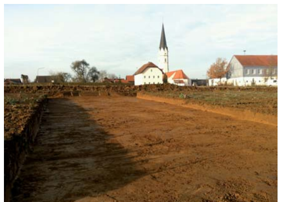
In der Entstehungsphase: Das Baugebiet Frauenbiburg
