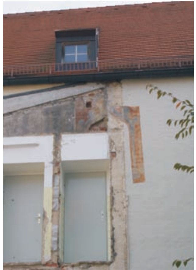
Teilweise freigelegtes Wappen der Vizedome an der Westseite des Kastens
