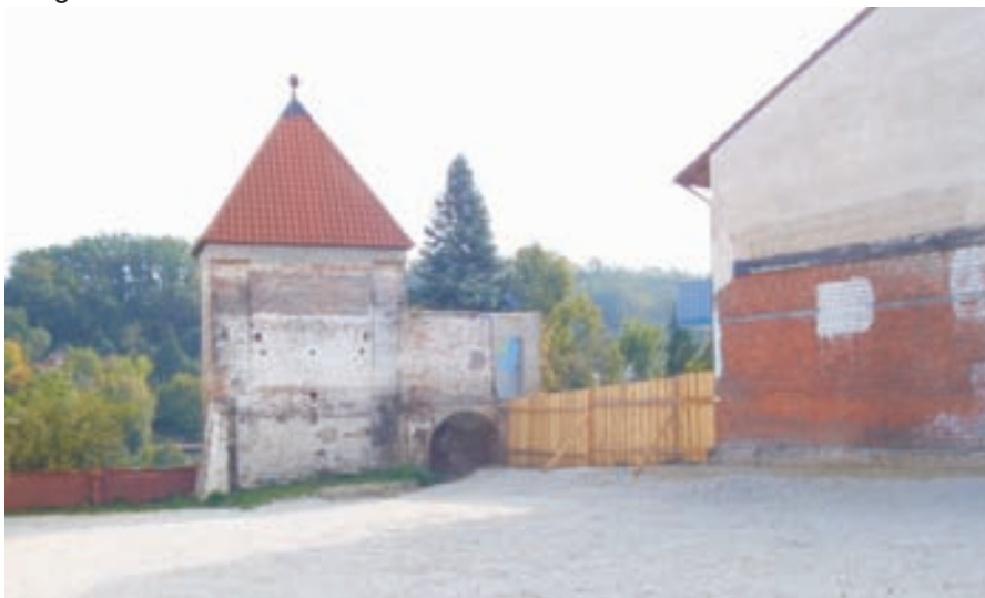
Blick auf das freigeräumte Gelände und den Stinkerturm. Hier entsteht das Eingangsportal und die Gastronomie zum Museumsquartier
