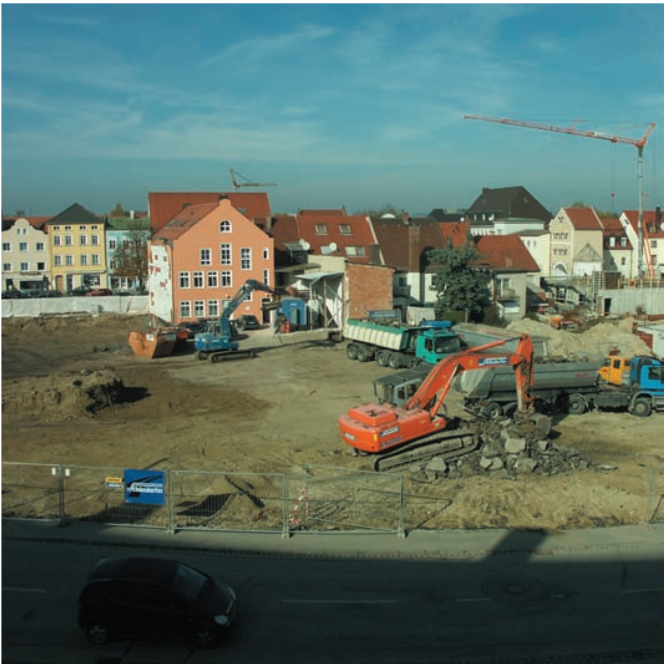
Großbaustelle Tiefgarage Altstadt
