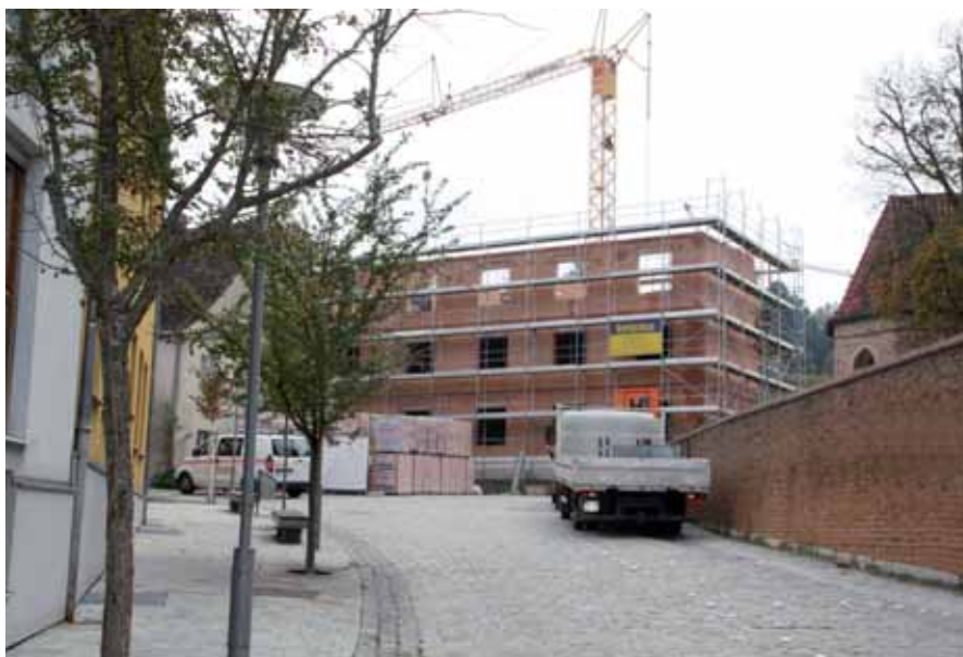
Die Baustelle an der Kirchgasse: hier entsteht die Erweiterung
