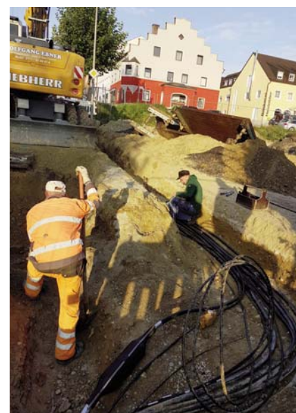
Leitungen werden umgelegt
