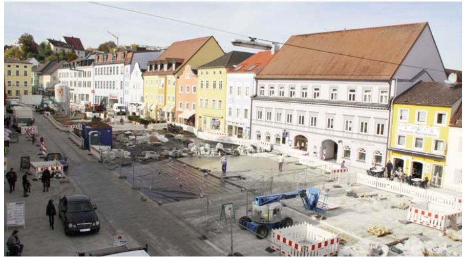
Die Südseite und die Fahrbahn sind bereits fertiggestellt
